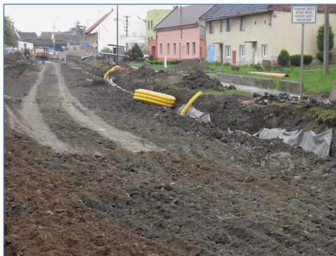
Snímek rozkopané komunikace ve směru od knihovny ke křižovatce.
