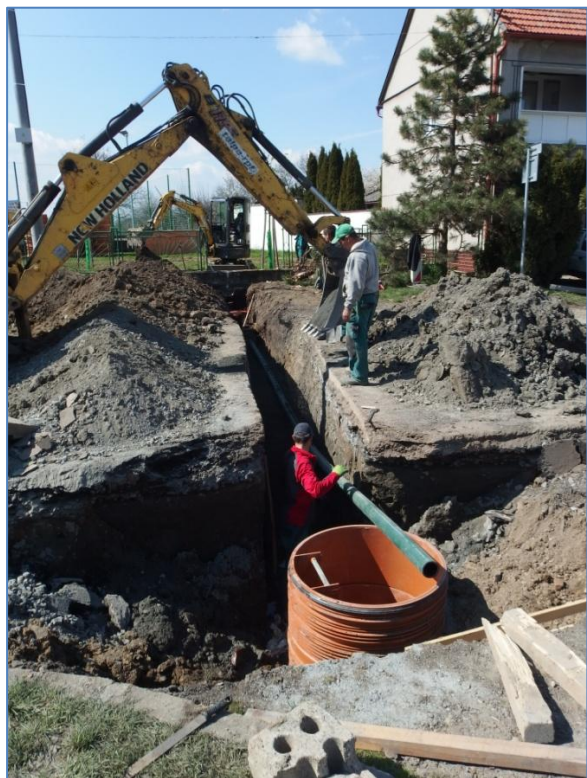
Stavba výtlačku čerpací stanice před sportovním areálem.
