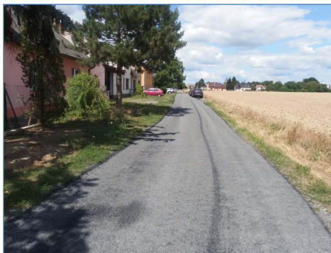
Nově byla opravena také komunikace před domy ve směru od Chropyně.
