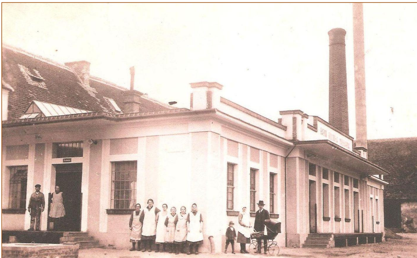
Takto vypadala Parní rolnická mlékárna v Kyselovicích po rekonstrukci.
