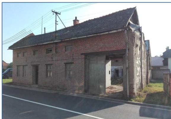
Poslední okamžiky domu č. p. 78 před jeho demolicí.
