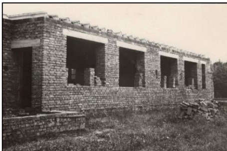
Stavba budovy mateřské školy v Kyselovicích.
