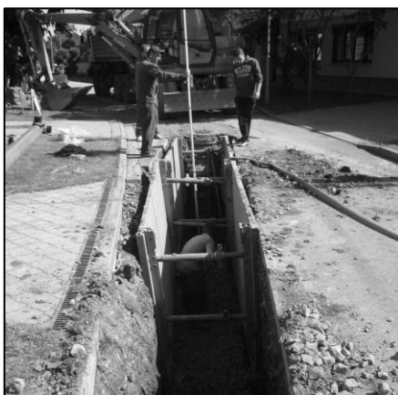
Výkopové práce před č.p. 227.
