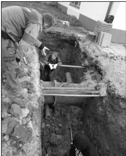
Kanalizační přípojka Obecní knihovny. Při budování přípojek bylo třeba přípojky v této ulici položit pod starou kanalizací, která je po obou stranách vozovky
