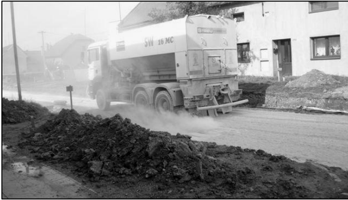
Podloží komunikace ve směru na Chropyně vykazovalo nízké, tedy špatné hodnoty a proto bylo podloží provápnit.
