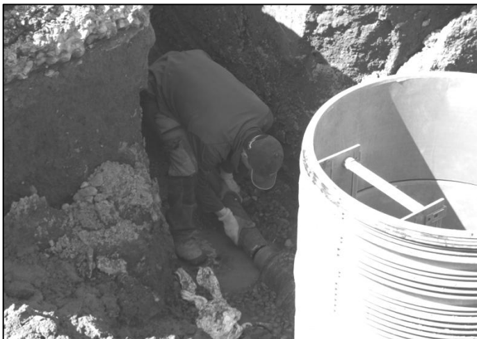
19. dubna 2015. Pracovník napojuje výtok z čerpací stanice.
