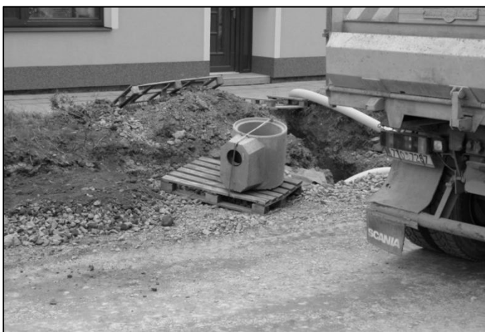
25. května 2015. Po stranách vozovky se osazují dešťové vpusti.
