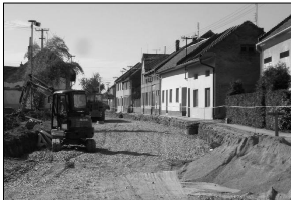
Na snímku je závěrečné etapa rekonstrukce silnice II. třídy číslo 463 ve směru na obec Vlkoš.
