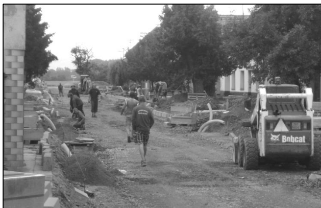
Rekonstrukce vozovky a následné opravy a úpravy terénu si vyžádaly nasazení značného počtu lidí a také patřičnou techniku.
