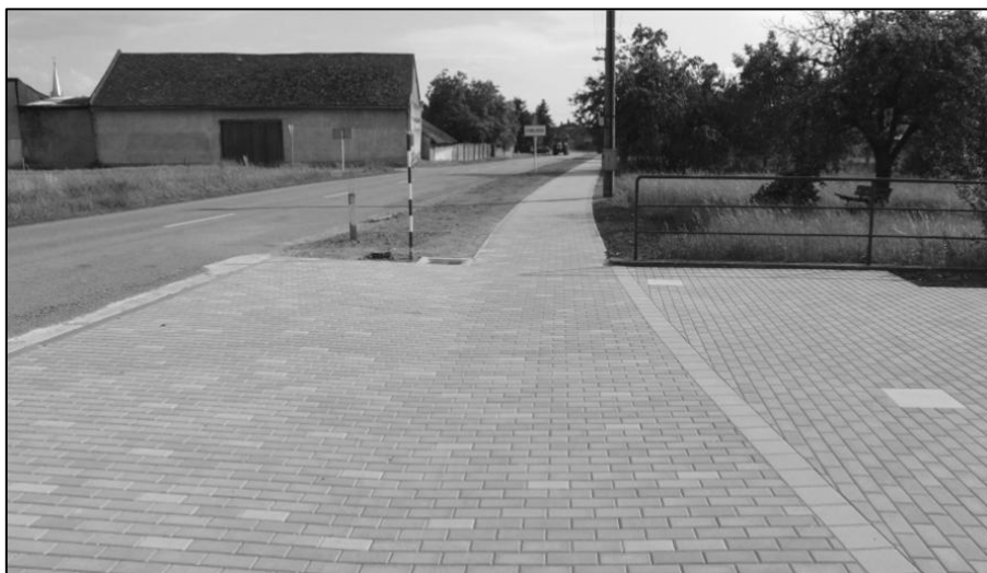
Nový chodník ke hřbitovu firma Cyril Dragon – Dlažba, Chropyně již dokončila
