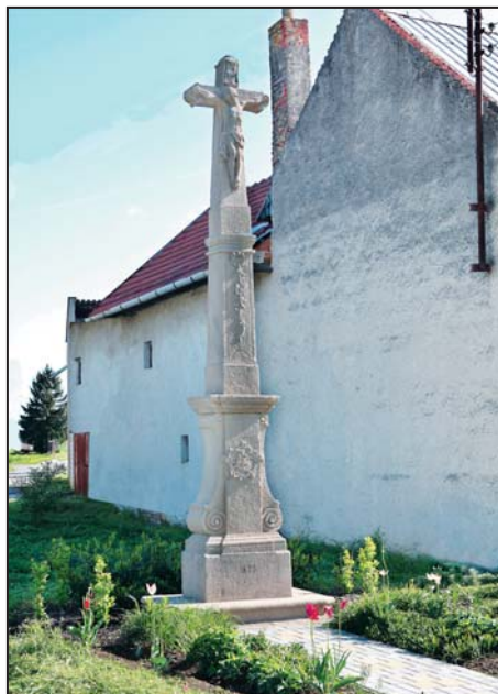
Kříž LP 1769 opravený v roce 2010.
