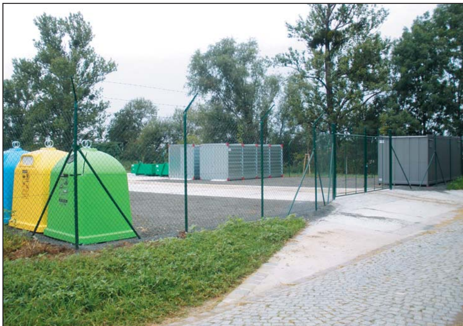
Odpadové centrum Kyselovice před otevřením v roce 2012.
